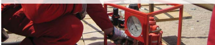
► Hydrostatic test pumps
