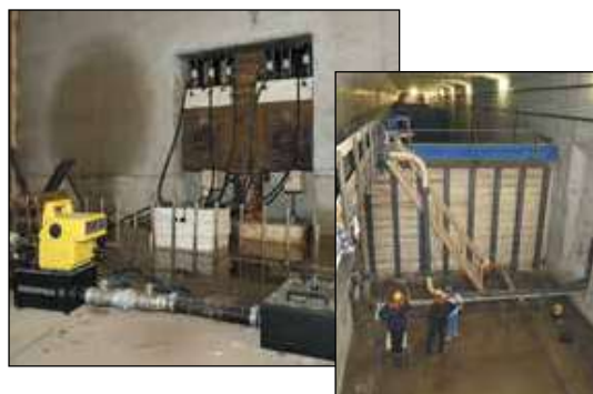
◀ Los cilindros livianos de aluminio RAC-506 de Enerpac son ideales para ambientes húmedos, tales como el de este túnel bajo el río (línea ferroviaria de alta velocidad de Holanda).
