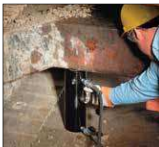
◀ Un RAR-506 se colocó fácilmente bajo un bulldozer para reparar un componente del bastidor.
