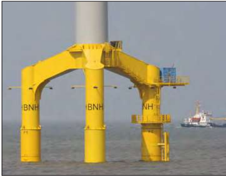
▲ Nivelación de turbinas eólicas mar afuera: El sistema de elevación síncrona de Enerpac proporcionó la solución para la nivelación de las piezas transversales de soporte para 80 turbinas eólicas.
