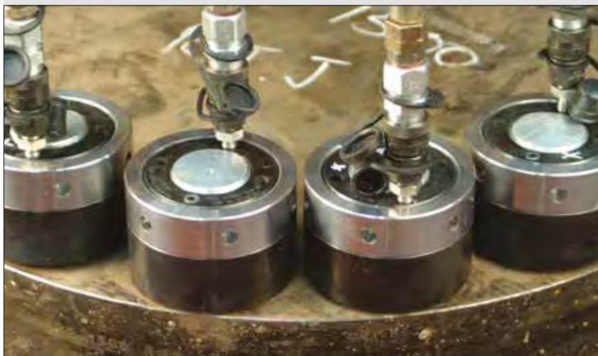
▲ Tensionado con tuercas hidráulicas.
