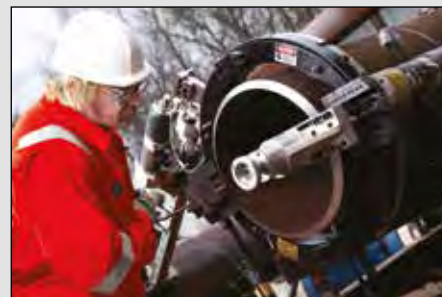
▲ Cortadoras de tubo y preparación de soldadura.
