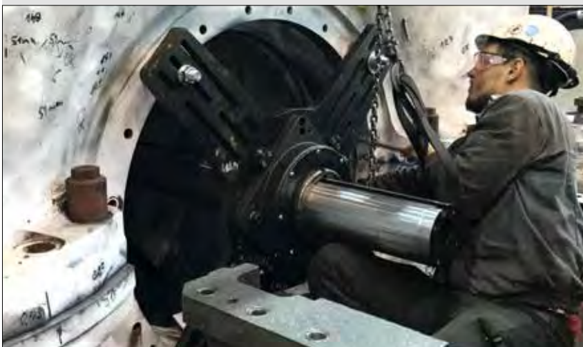
▲ Cortadoras de tubo y preparación de soldadura.
