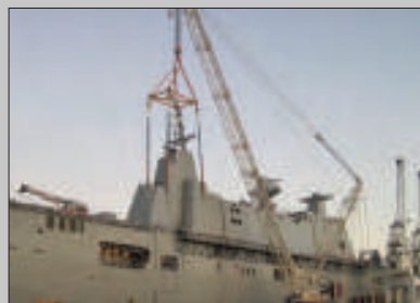
Elevación y colocación sincrónicas de carga
