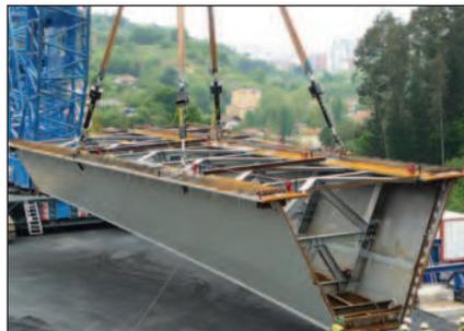
▼ Paquete de energía SyncHoist para operar los 4 puntos de elevación.
