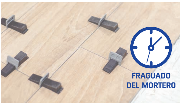
5 Esperar secado / Attendre que cela sèche / Allow for setting
