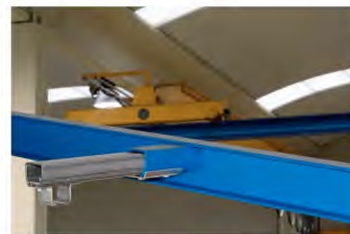
SOPORTES SOLDABLES A VIGA
