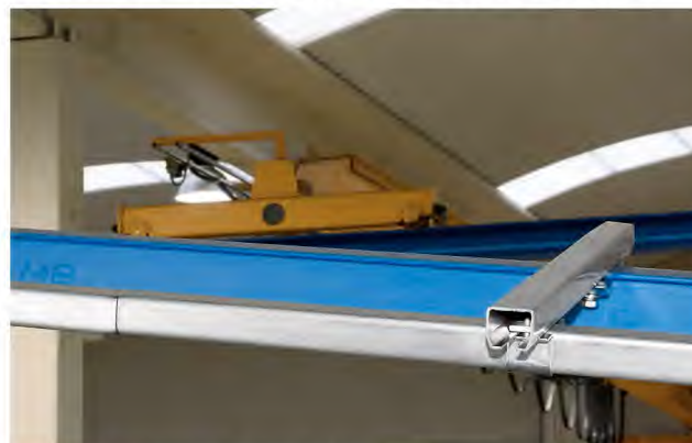
PLETINAS SOLDADAS A LA VIGA
