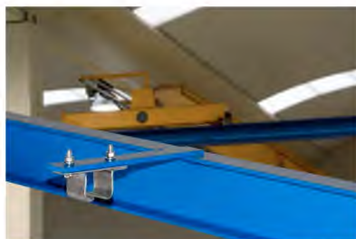
PLETINAS SOLDADAS A LA VIGA
